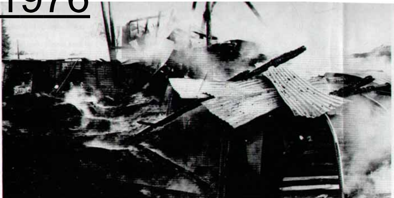
Raivoisa tulipalo teki nopeassa tahdissa selvää jälkeä lautarakenteisesta saharakennuksesta. Osa katosta oli sortunut jo ennen palokunnan saapumista paikalle. Yksi joen uomassa (kuvassa vas.) työskennelleistä palomiehistä sai savumyrkytyksen ja joutui käymään sairaalassa.
